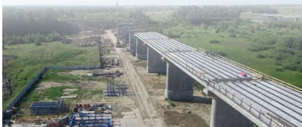
Пролетные строения эстакадной части моста через р. Суру
