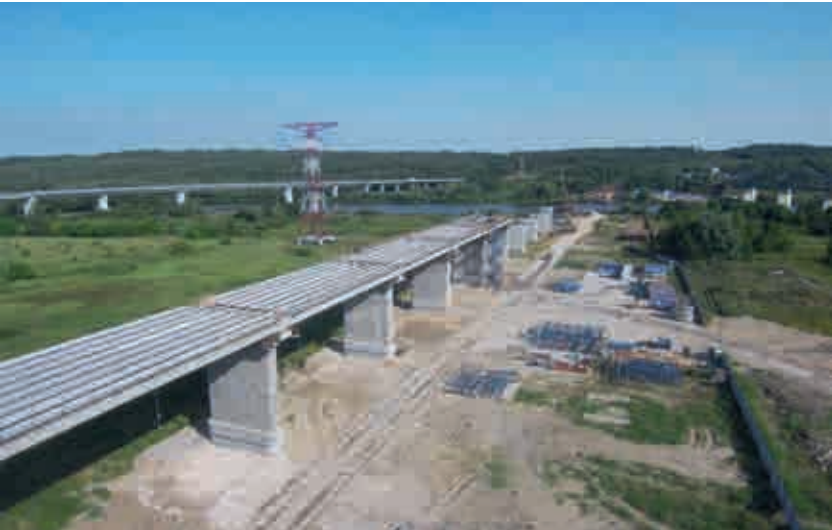
Возведение опор моста через р. Суру, 2-я очередь
