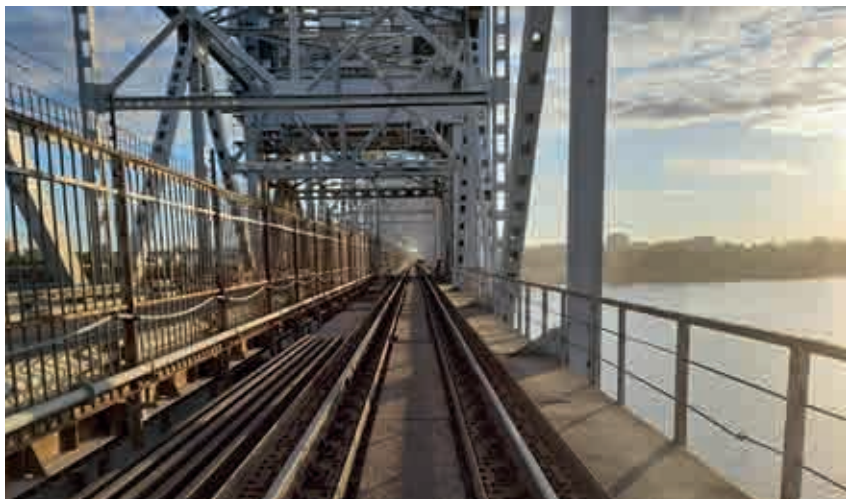
Капитальный ремонт моста через р. Северная Двина
