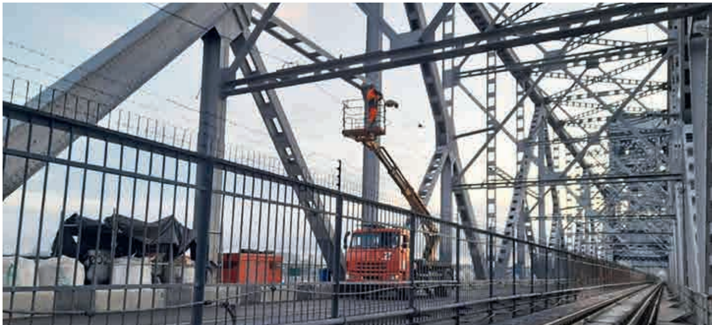
Капитальный ремонт моста через р. Северная Двина
