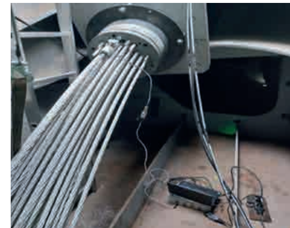
Рис. 3. Анкерный узел с датчиком усилия пряди СТС
