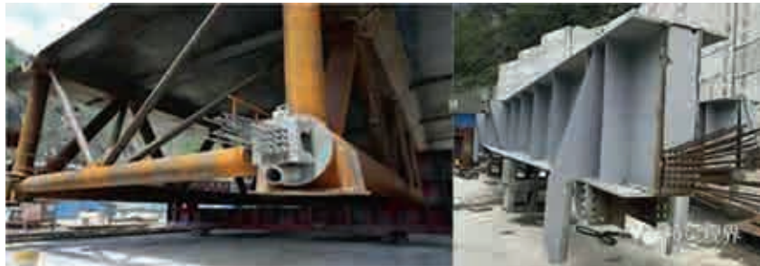
Преднапряженная конструкция стальной трубы моста, Китай
