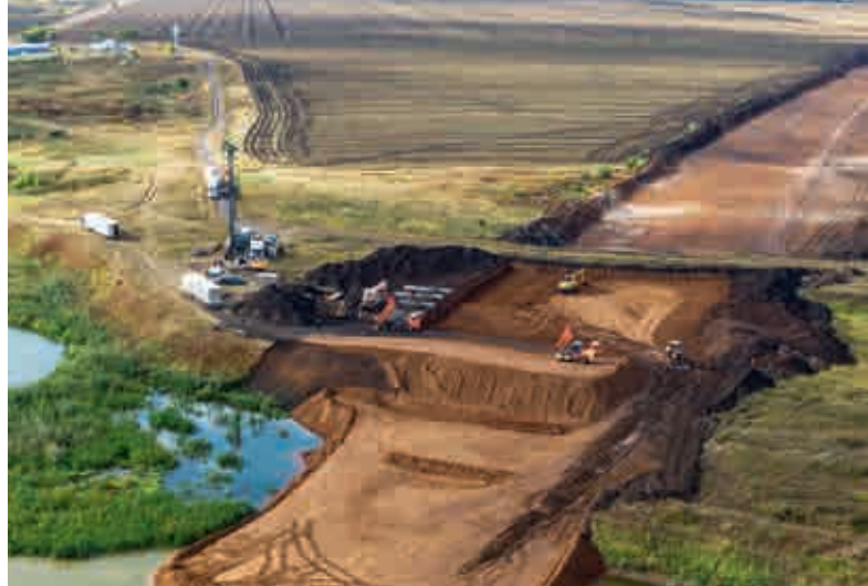
Строительство моста через р. Челну
