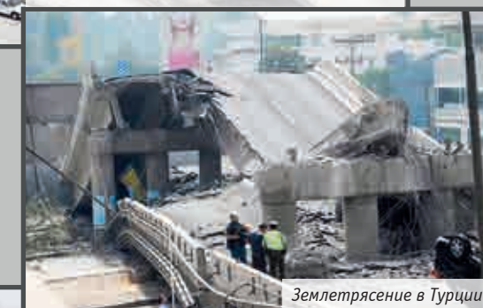
Разрушение мостов после землетрясения
