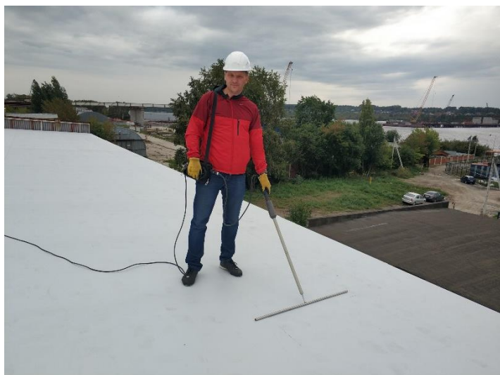
Рисунок 3. – Контроль целостности водоизоляционного ковра кровли из ПВХ мембраны с помощью электроискрового кровельного дефектоскопа ИЗОТЕСТ 2.0
