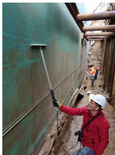
Рисунок 4. – Контроль герметичности гидроизоляции фундамента с помощью электроискрового кровельного дефектоскопа ИЗОТЕСТ 2.0
